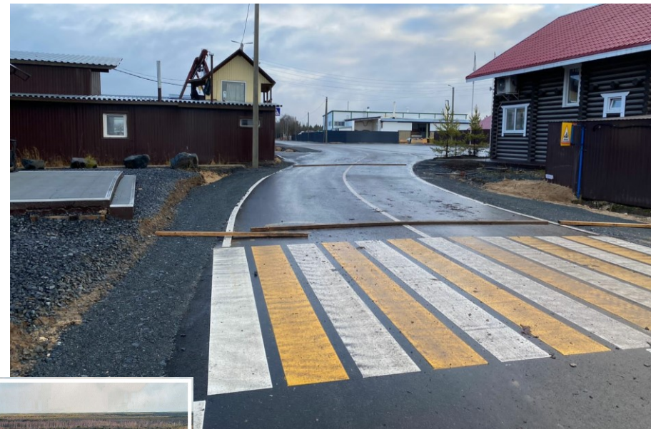
Реконструкция участков автодороги местного значения на территории пос. Строитель Плесецкого округа
