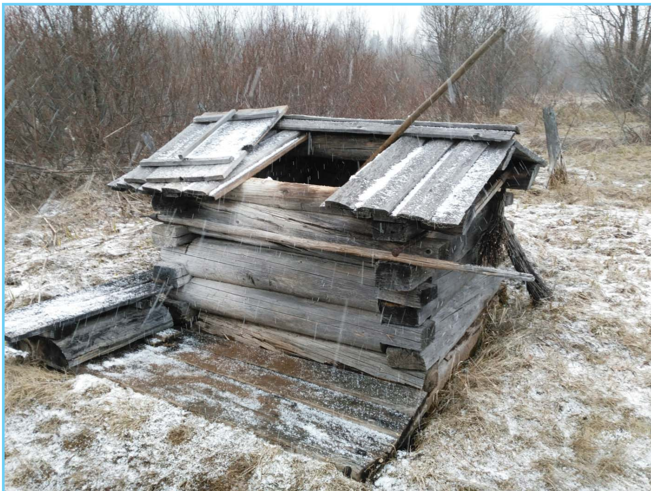
Необходимо обновление или восстановление сруба, замена деревянного настила на тропе. Фото Э. Шашина.
