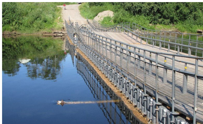
Приобретение наплавного моста через реку Емца
