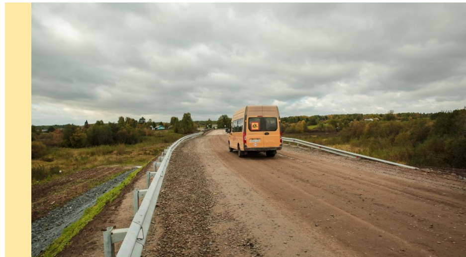
Реконструкция автомобильной дороги Усть-Ваеньга – Осиново – Фалюки на участке км 85 – км 97 в Виноградовском районе
