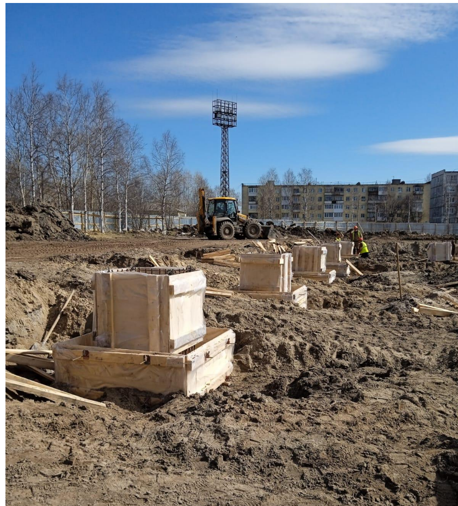
Здание крытой ледовой арены на территории стадиона "Север" в Северодвинске
