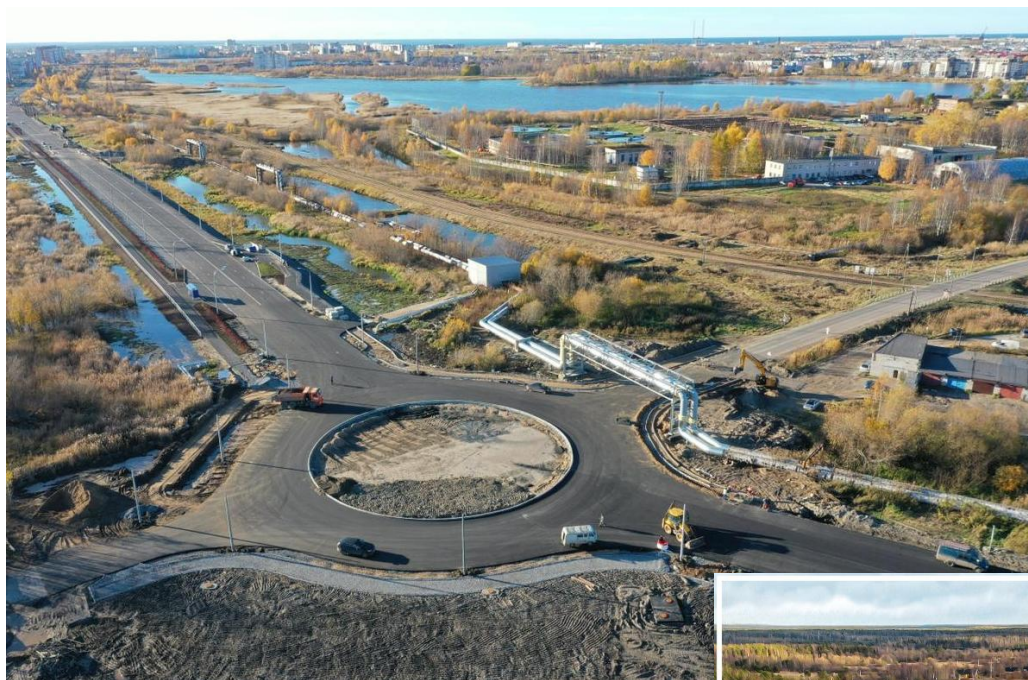
Окружная дорога (соединение ул. Окружной с ул. Юбилейной) в г. Северодвинске
