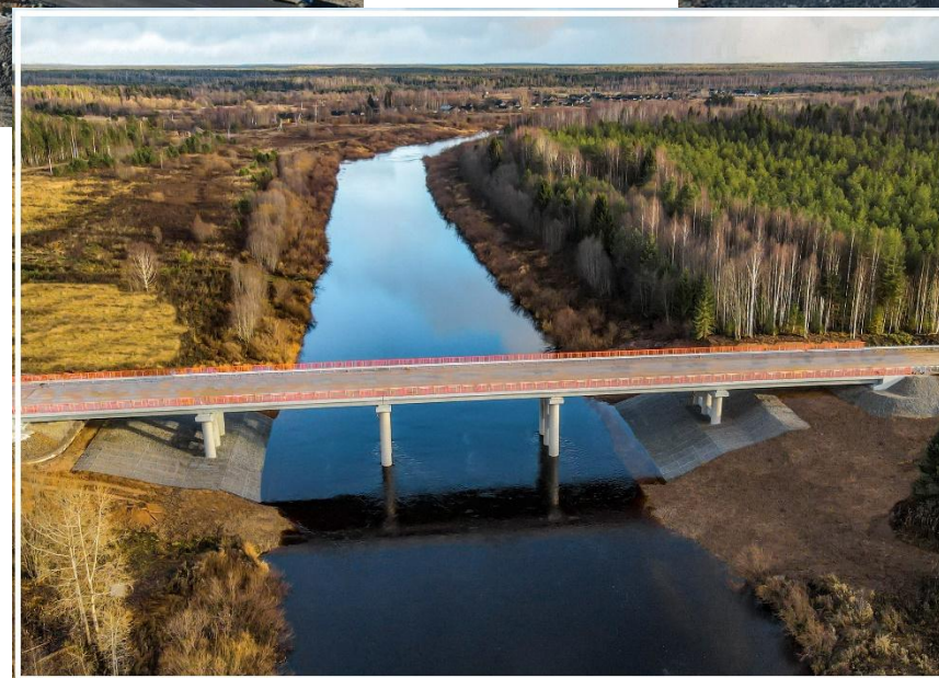
Мостовой переход через реку Устья на км 139+309 автодороги Шангалы-Квазеньга-Кизема
