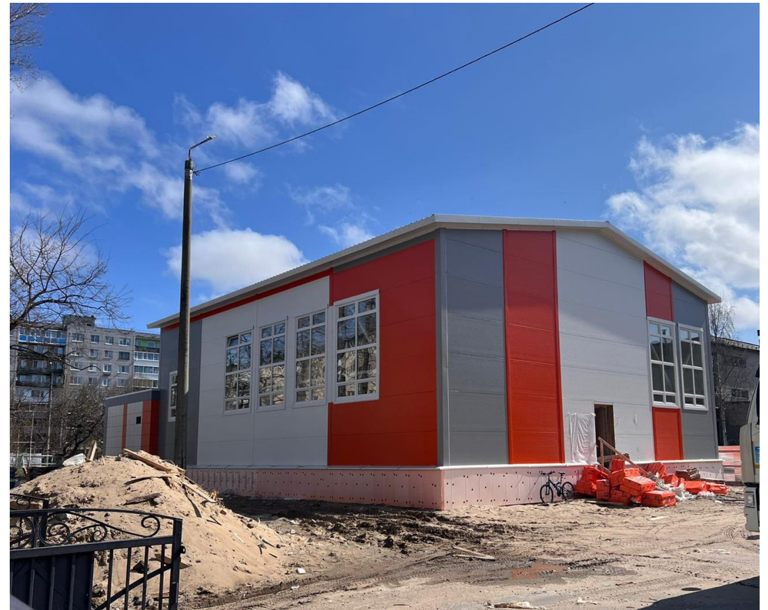
Реконструкция здания теплицы школы № 10 под спортивный зал
