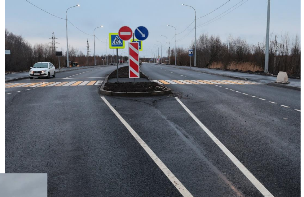
Автодороги в рамках комплексной застройки квартала № 152. Ул. Ленина
