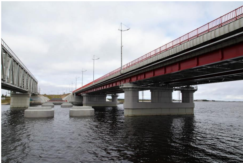
Реконструкция моста через Никольское устье Северной Двины в г. Северодвинске
